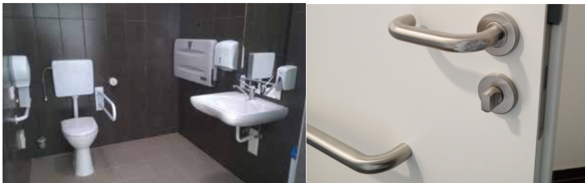
fénykép kontrasztos, megfelelően felszerelt wc helyiségről, wc ajtó szerelvényeiről
